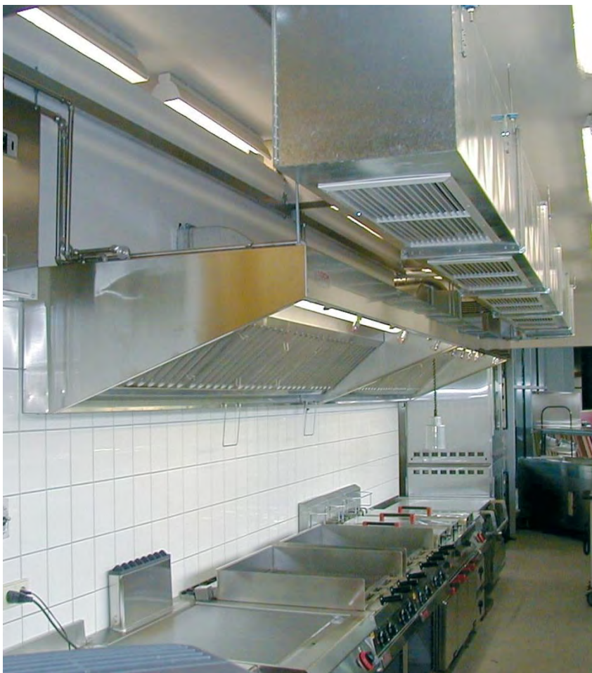
Abb. 8: Kleinlöschanlage für Fritteusen
